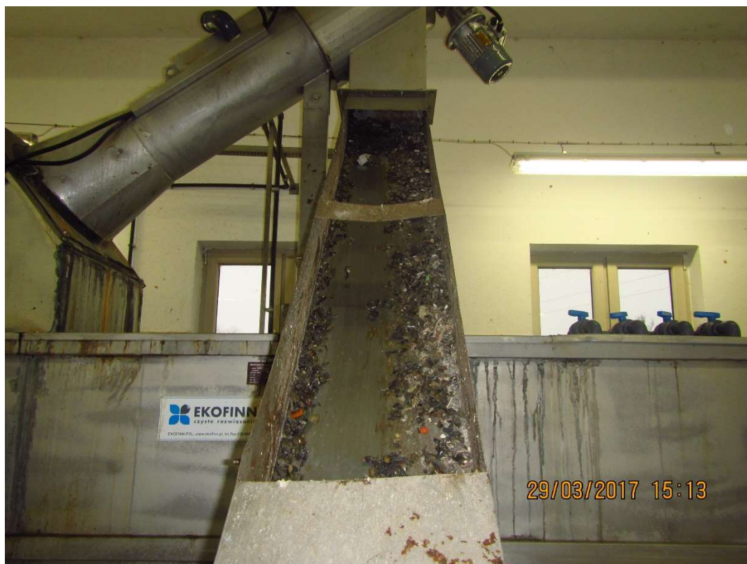
Transporter skratek z otwartą rynną zrzutową. Niezgodne z PFU.
